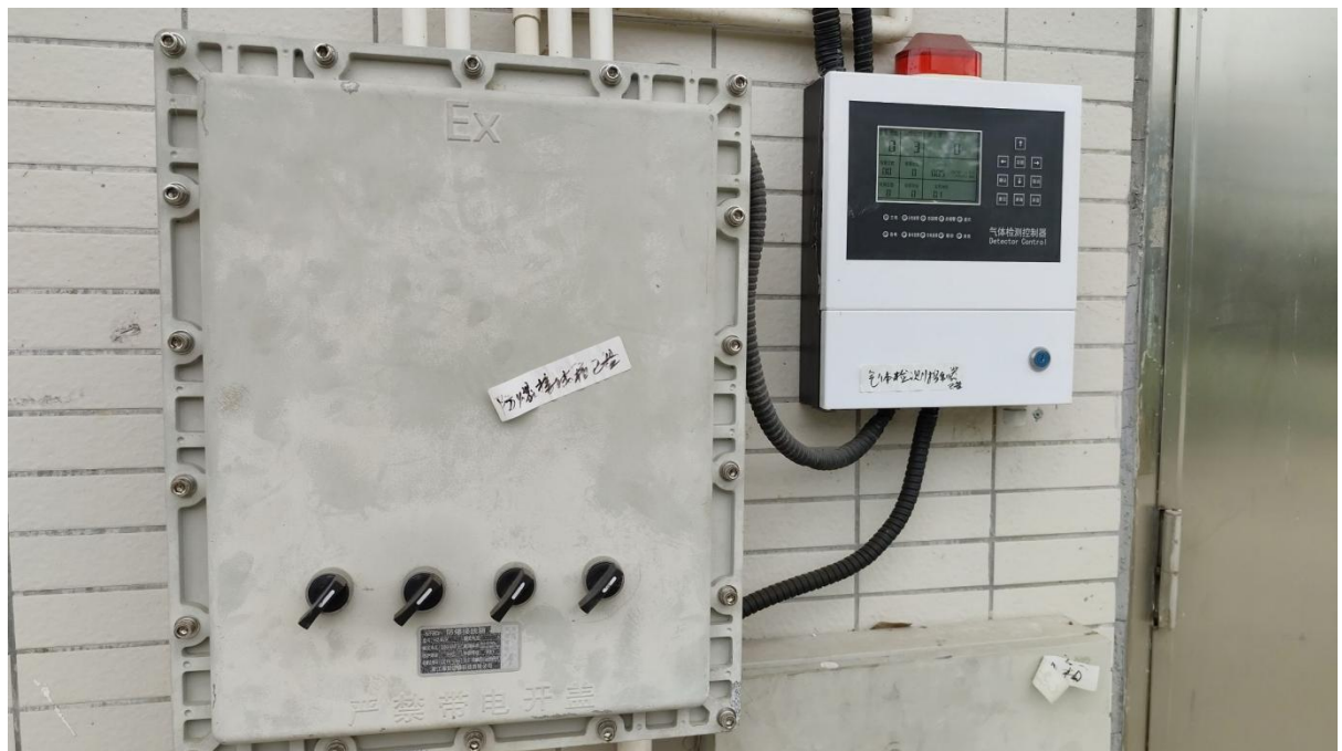
图 2.8-3 有毒有害气体超标报警器
